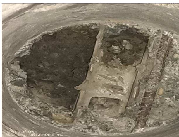
Foto č.16 – detail spodní úrovně provedené vrtané sondy VS1
